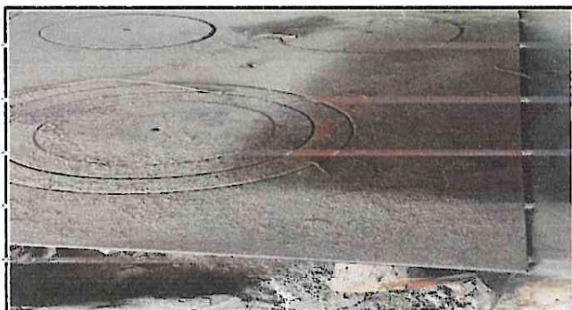
Foto 3: Sustitución de Plancha en la cocina
